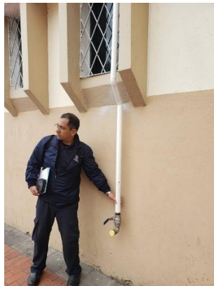
Fotografía 4. Inspección de sistemas de gases combustibles
