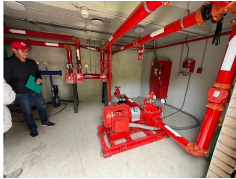
Fotografía 3. Verificación de sistemas contra incendios
