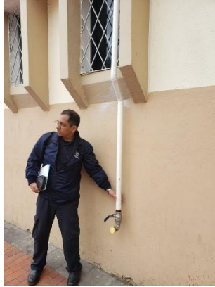
Fotografía 4. Inspección de sistemas de gases combustibles
